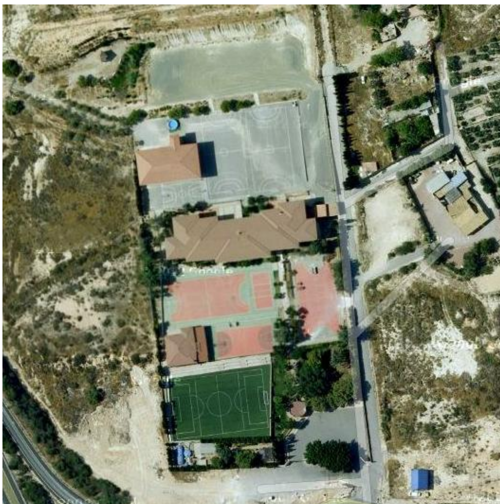
Figura 1: Vista aérea del colegio Aitana
