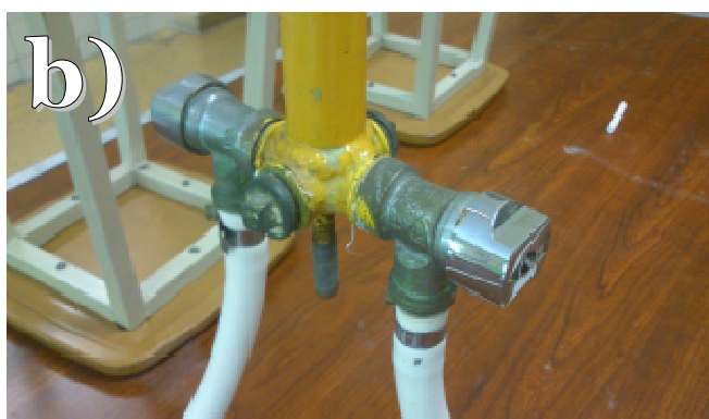
Figura 6. Mecheros fijos en el laboratorio químico del colegio San José de Calasanz. a) Instalación de gas en el laboratorio. b) Detalle de la llave de paso del mechero. c) Mechero con soporte y rejilla. (Fuente: Elaboración propia)
