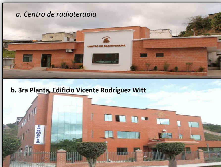
Figura 3 Áreas físicas remodeladas
