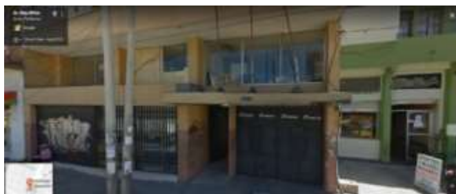
Figura 19. Fachada y acceso principal al instituto. (Google maps, (s.f.))
