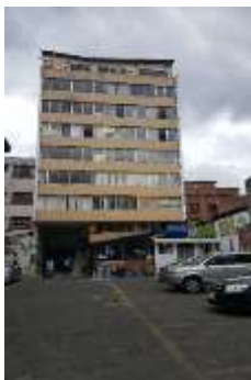
Figura 10. Vista posterior de la institución desde el área de parqueaderos. (Elaboración propia)
