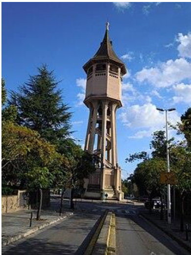
Figura A. 1. Torre de l'Aigua
