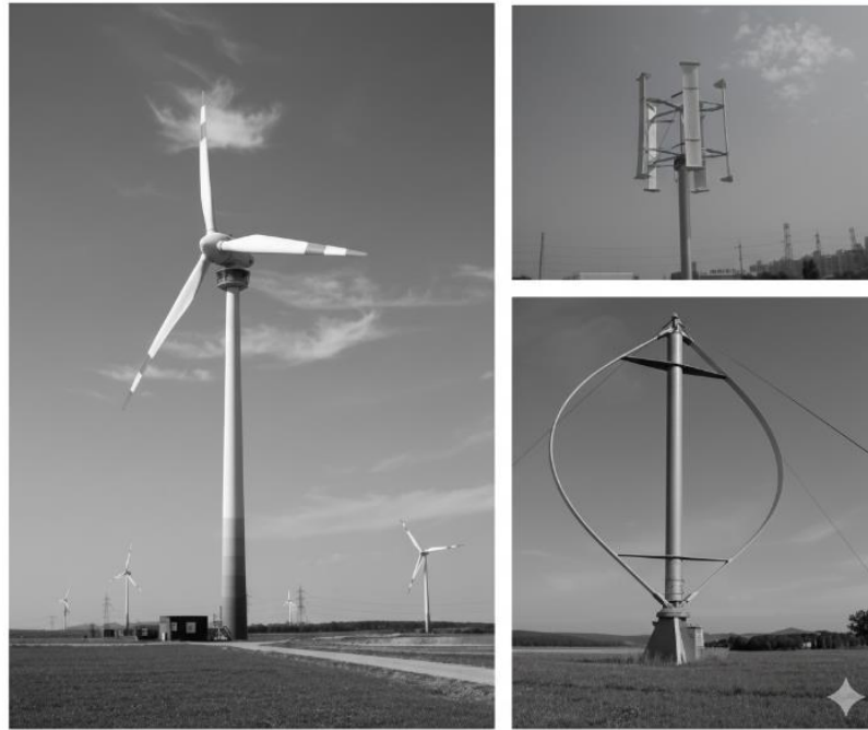
Figura 26:Aerogeneradores de eje horizontal y de eje vertical.
