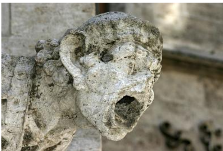
Figura 7. Imagen de una gárgola deteriorada por la lluvia ácida (Universidad Complutense de Madrid, s.f.)
