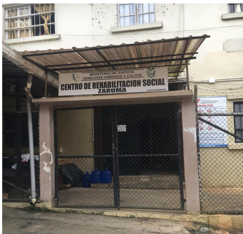
Puerta de Ingreso al CRS-Z. Zaruma, junio del 2019
