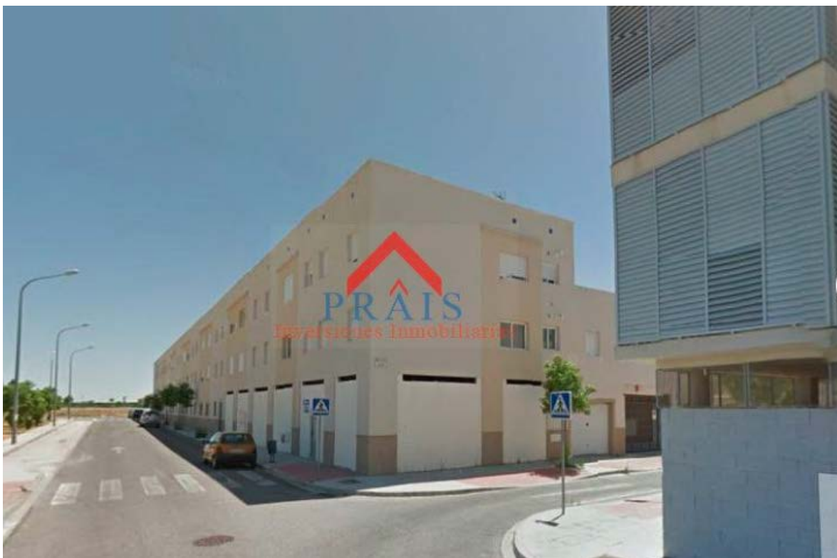
VISTA EXTERIOR DEL LOCAL COMERCIAL SELECCIONADO
