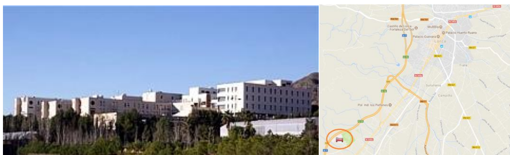
Figura 2. Vista panorámica y ubicación geográfica del Hospital Universitario Rafael Méndez de Lorca FUENTE: www.murciasalud.es . Portal sanitario de la Región de Murcia.
