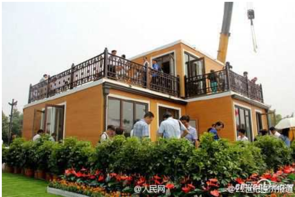
Figura 4. Casa fabricada mediante impresión 3D.
