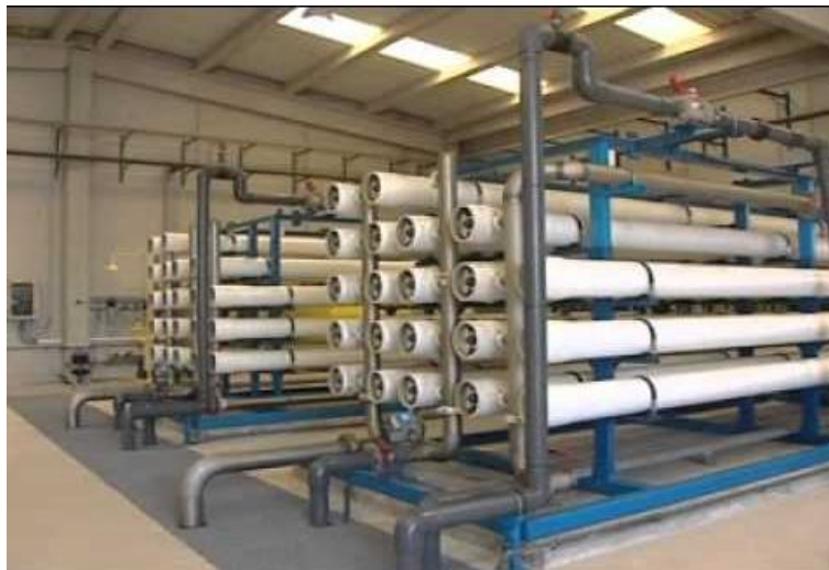
Ilustración 12. Filtros para el tratamiento de agua previo. (FACSA, 2016)
