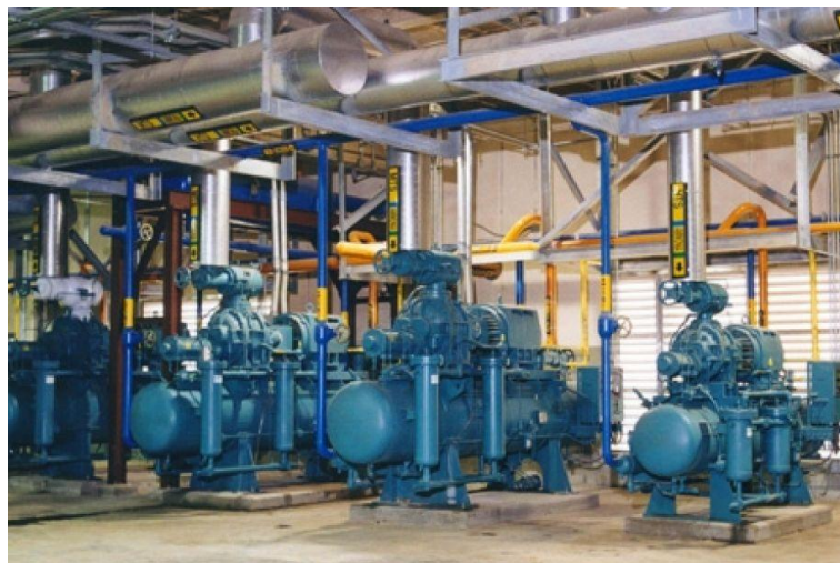
Ilustración 11. Detalle de planta de producción de frío. (Food Plant Engineering, 2016)
