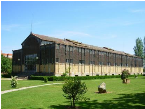
Imagen 1. Edificio metálico situado en el Campus. (Corbacho, s.f.)
