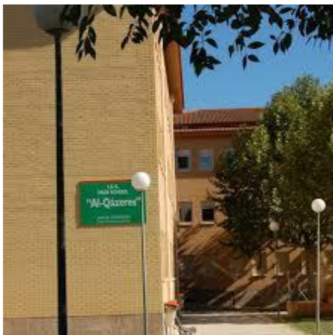
Vista del acceso principal al IES Al-Qázeres.
