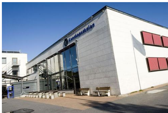
Figura 4: Exterior de la escuela. Estas escuelas no suelen ser espectaculares por fuera y suelen estar construidas en antiguas fábricas, granjas o espacios comerciales.
