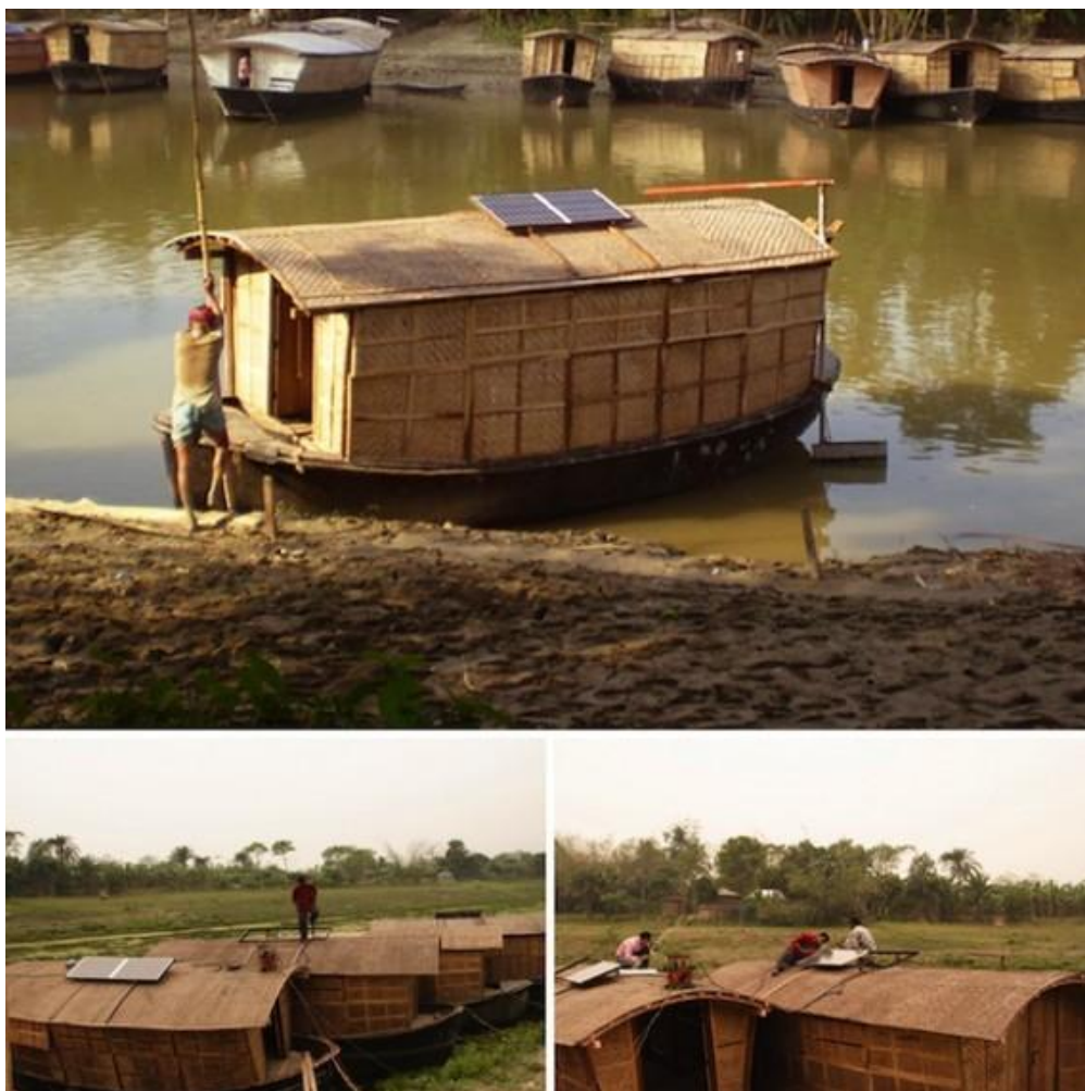
Figura 45: Gente local colaborando en la construcción de las escuelas ( http://tec.nologia.com/2012/11/20/las-escuelas-flotantes-de-bangladesh-con-paneles-solares/ ).
