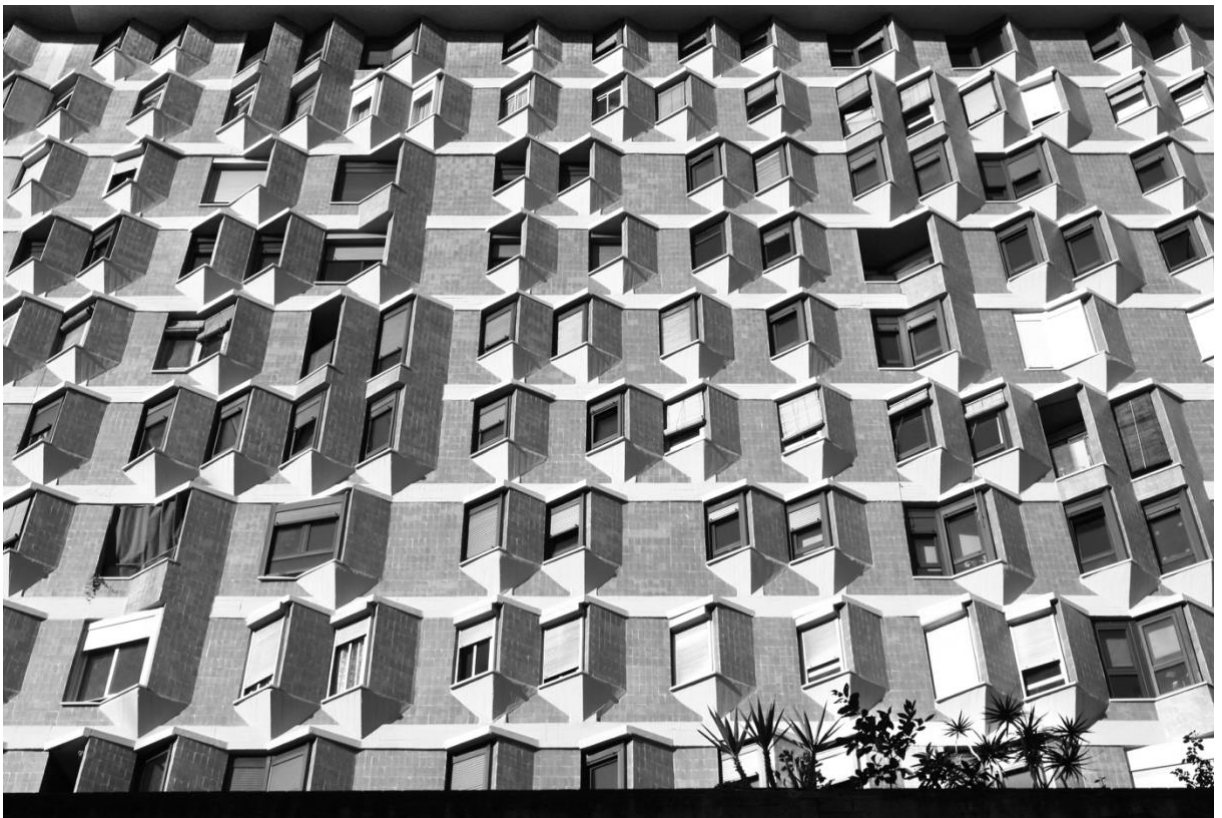
Figura 26. Av. Meridiana 314-318, (MBM Arquitectes, 1965), desde la Plaza de la Asamblea de Cataluña, 2025
