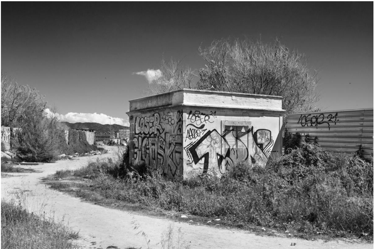
Figura 15. Casita transformadora, Puente del Trabajo Digno, 2025
