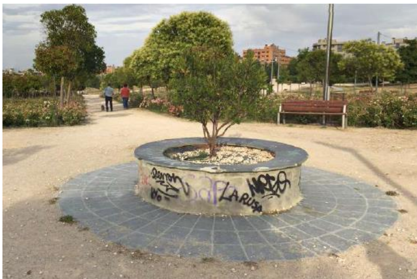
FIGURA 10. Macetero de hormigón sobre el que versa la tarea 3
