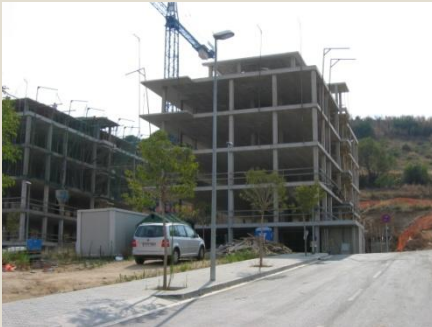
Estructura de hormigón armado
