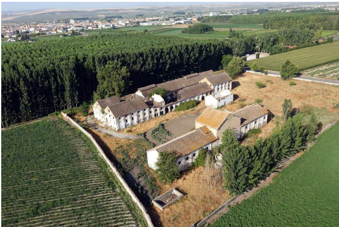
Figura 1 Fábrica de Nuestro Señor de la Salud. Estado actual. Fuente: Proyecto Refabrica 3 Da_
