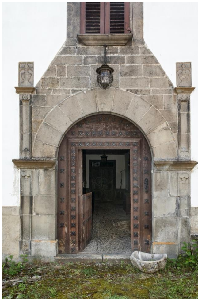
Foto 1: Etseborta de Casa Santxogarde.
