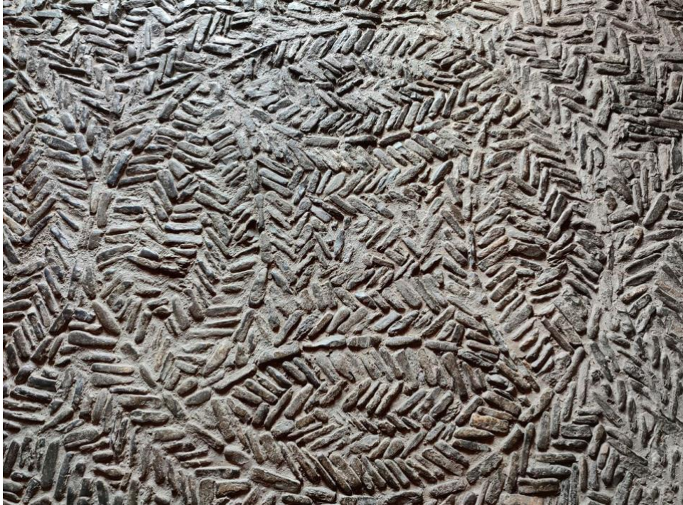
Foto 2: Suelo sobre tierra sin mortero.
