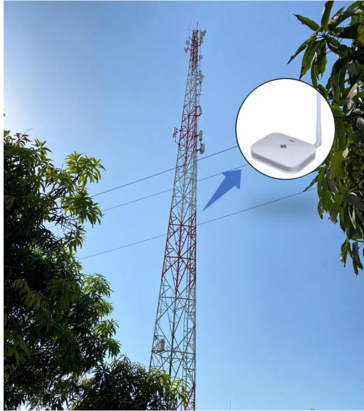
Figura 44. Torre de recepción.
