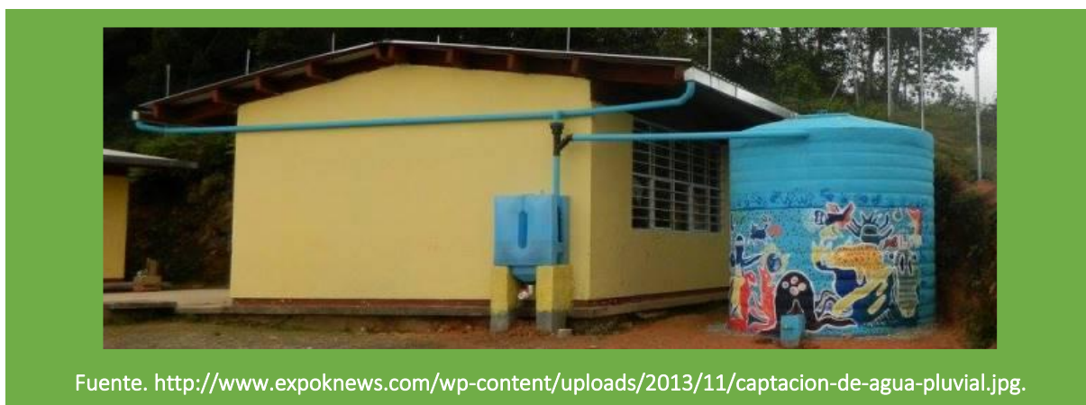
Figura 7. Captación y almacenamiento de agua lluvia
