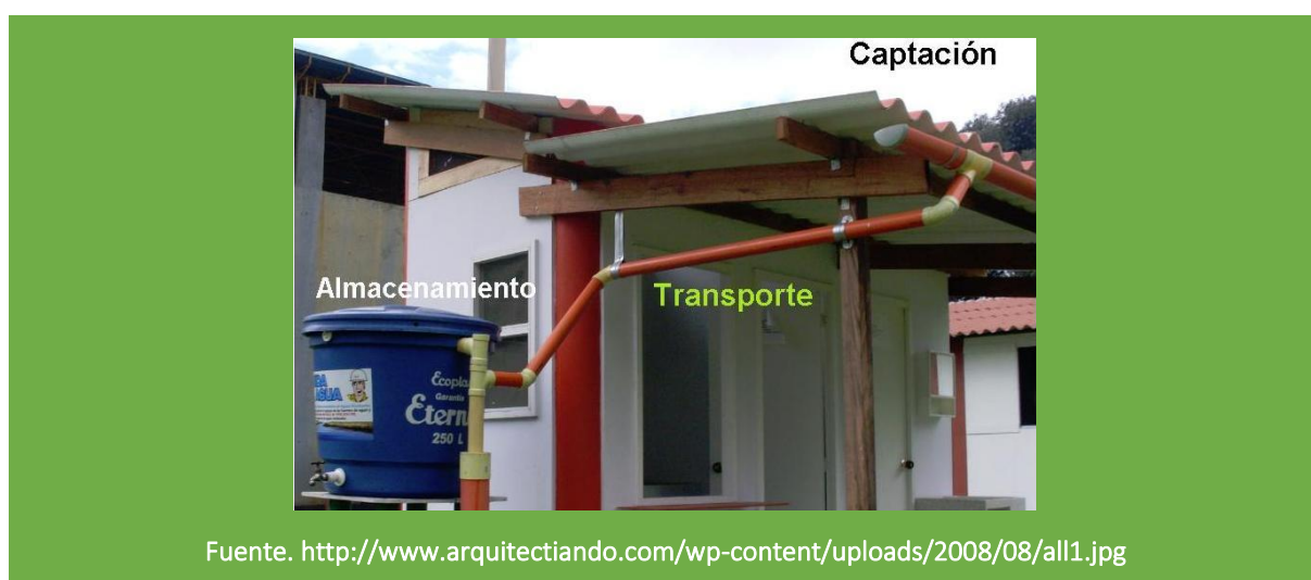
Figura 4. Captación y almacenamiento de agua lluvia
