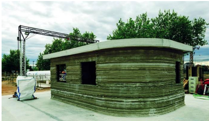
Figura 25. Primera casa levantada en España con impresión 3D.
