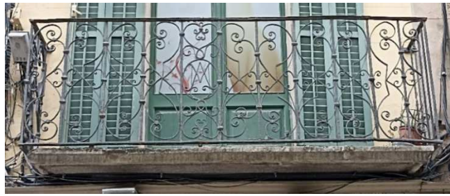
Figura 16. Barandilla de un edificio de la Rambla de la Llibertat de Girona.
