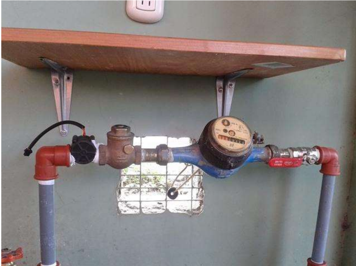
Figura 2-5. Sistema de medición de consumo de agua basado en un sensor Hall
