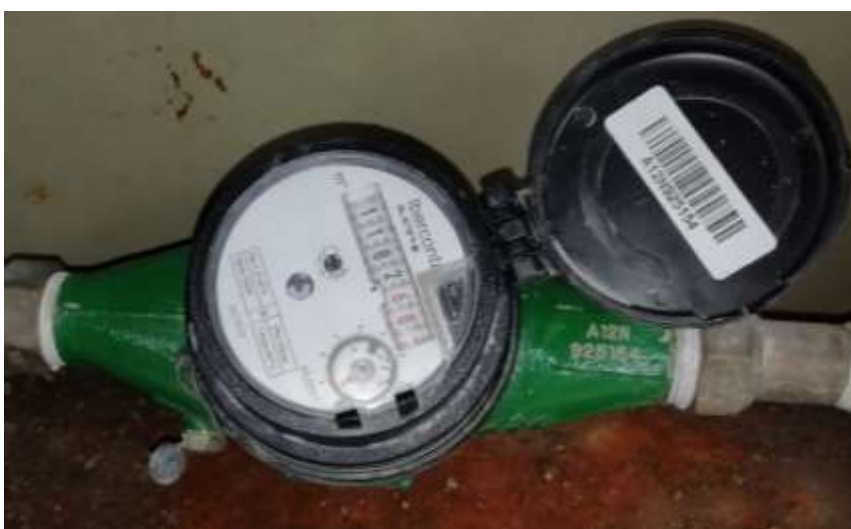
Figura 2-11 Medidor de chorro múltiple
