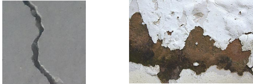
Fig. 3 Izq.: Imagen de una grieta perteneciente al data set "Concrete Crack Images for Classification". (Fuente: https://data.mendeley.com/datasets/5y9wdsg2zt/1 ) Dcha.: Imagen de un desconchado en una pared (Fuente: Internet)
