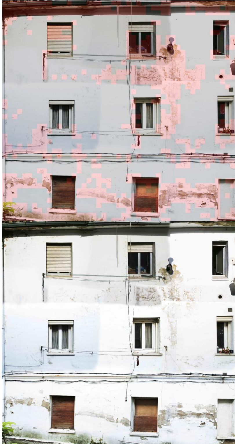
Fig. 20 Imágenes correspondientes a la salida (arriba) y entrada (abajo) de la herramienta, para fachada de un edificio compuesta por 12 imágenes tomadas con dron.
