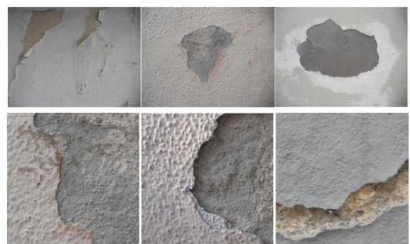
Fig. 1 Muestras de imágenes de la clase positiva del data set confeccionado por el autor, “Delaminations2021”; la fila de arriba está compuesta por imágenes completas (mapas) y las de la fila inferior son el resultado del fragmentado o corte.
