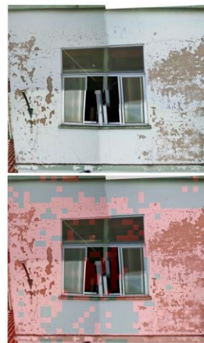
Fig. 6 Imagen sintetizada manualmente a partir de 4 imágenes tomadas por el dron. Abajo: Resultado de insertar la imagen anterior a la herramienta desarrollada.
