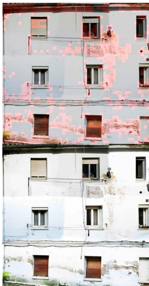
Fig. 7 Imagen de una fachada sintetizada manualmente a partir de 12 fotografías tomadas por el dron. Arriba: Resultado de la aplicación de la herramienta. Abajo: composición original.
