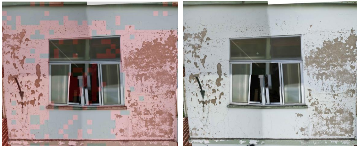
Fig. 21 Ejemplo de uso de la herramienta para un mapa confeccionado a partir de cuatro imágenes tomadas por dron. Mapa de entrada (dcha.) y mapa de salida (izda.)
