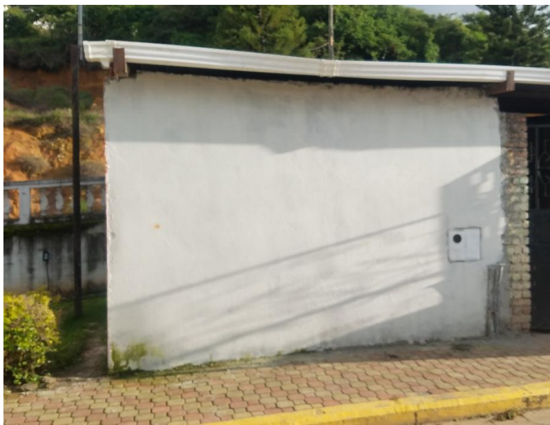
Figura 28. Curación Muro 3. Fuente: colectivo Áurea
