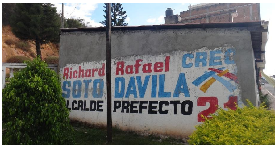
Figura 24. Muro 2. Fuente: colectivo Áurea
