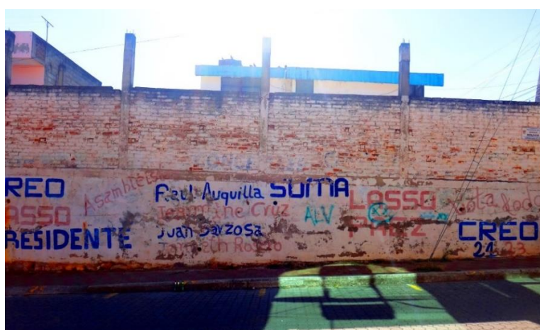
Figura 19. Muro 1. Fuente: colectivo Áurea
