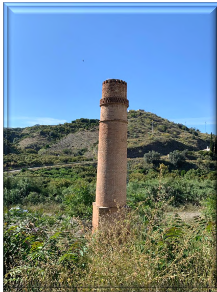
Figura 28. Chimenea. (Elaboración propia).
