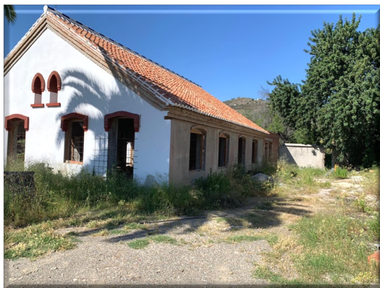
Figura 23. Restauración del tejado morisco. (Elaboración propia).
