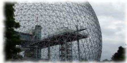
Fig 32: Cúpula geodésica: "Montreal Biosphère".
