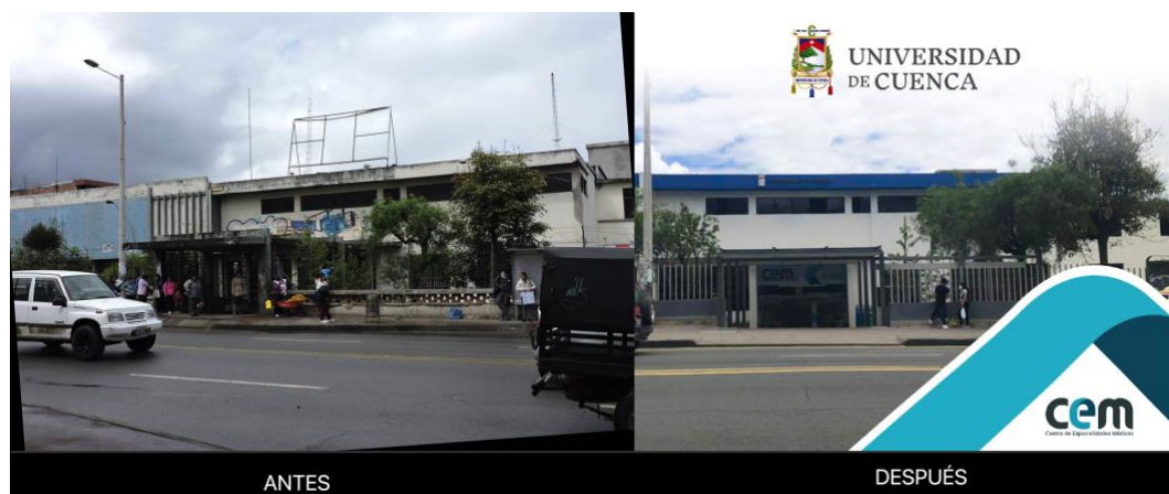
Figura 2. Campus Huayna Cápac de la Universidad de Cuenca, antes y después de rehabilitación.
