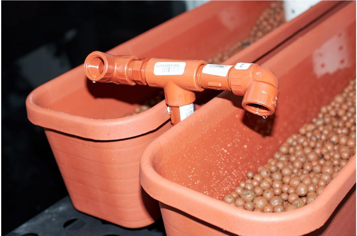
Figura 76. Tubería a las macetas modificación (I)
