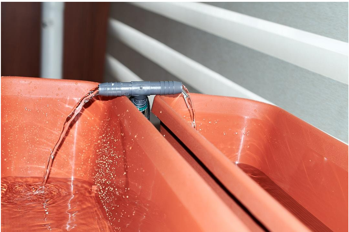
Figura 75. Tubería a las macetas
